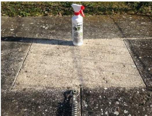
Etat final après brossage eau + R155 + rinçage final à l'eau claire puis séchage !
